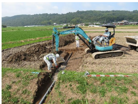
T字集水柵設置
